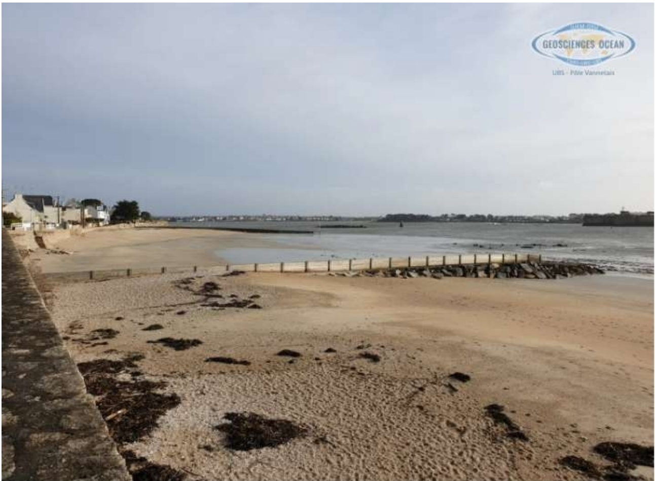
PHOTO DES DEUX ÉPIS INSTALLÉS À LA NOURRIGUEL (SOURCE : LGO 2019)
